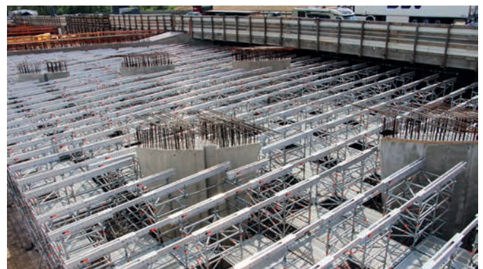
Fertig montiertes und eingemessenes Traggerüst
